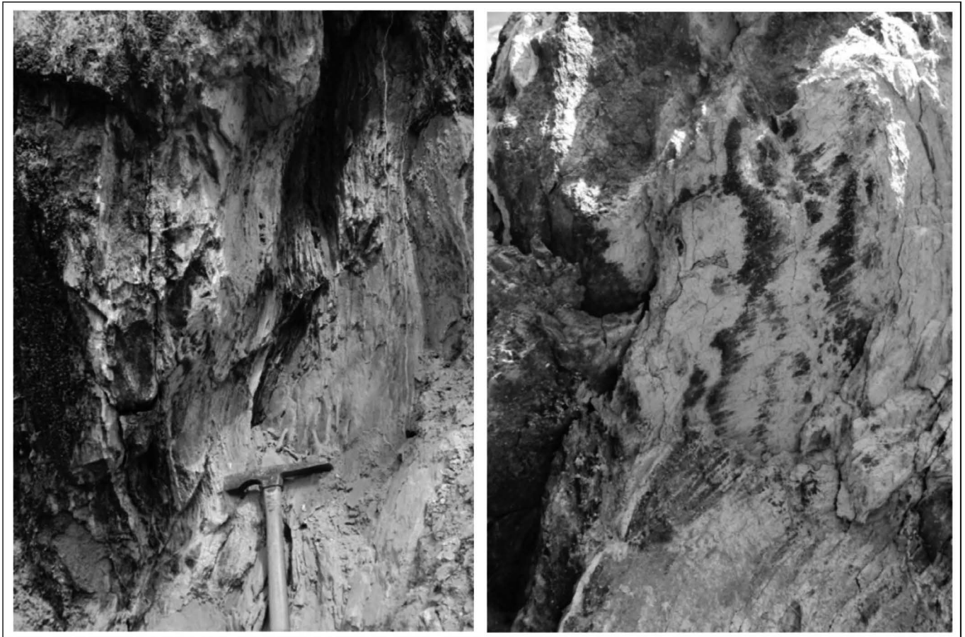
Figura 19 - Par de falhas inversas afetando filitos alterados em afloramento na Rodovia Transamazônica, cortando os traços da foliação / bandamento composicional. Na esquerda, planos de falhas inclinados para SE e SSE (lado esquerdo da foto). À direita, vista (de baixo para cima) do plano estriado de uma das falhas da foto ao lado, com estrias marcadas sobre o material ferruginoso da crosta laterítica.
