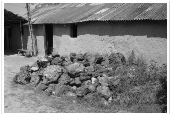
Figura 11 - Amontoado de blocos de laterita expostos à venda – Cajueiro – São Luís-MA.
