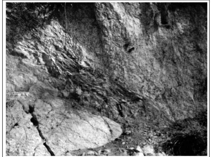
Figura 21 - Zona de "caixa de falha" de movimentação inversa em afloramento, afetando rochas graníticas alteradas e, principalmente, material argilo-arenoso com alteração de horizonte plíntico (ou mosqueado). Os planos de falhas mergulham com baixo ângulo para NW.
