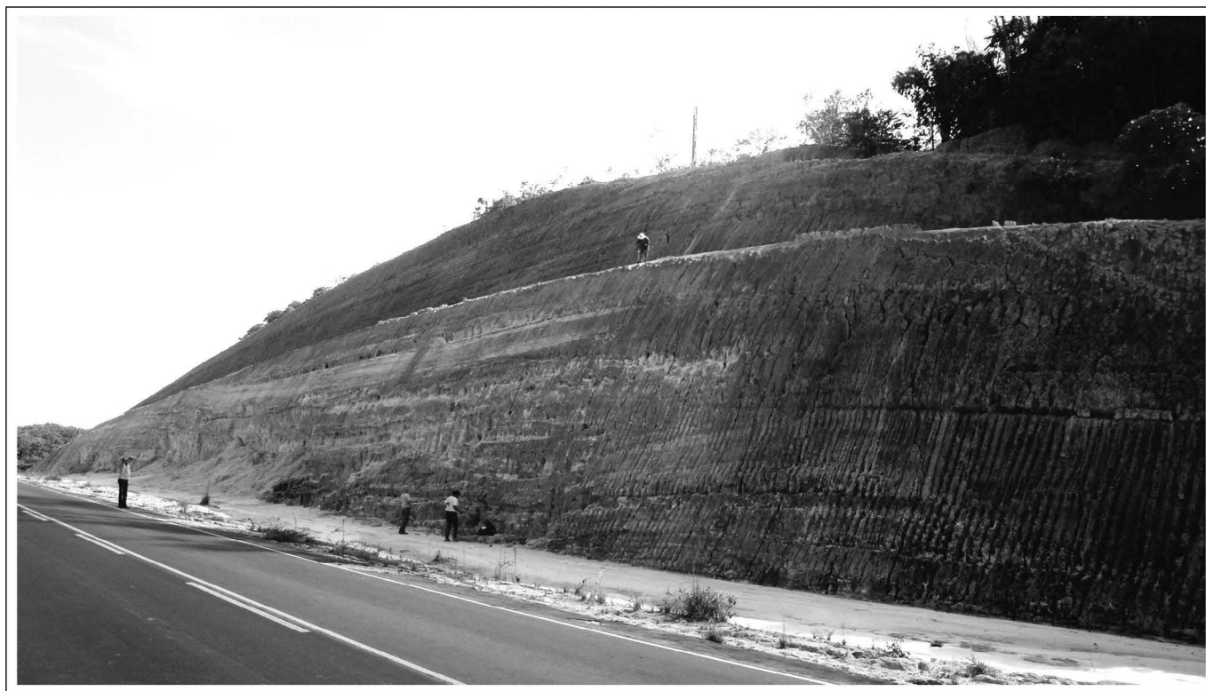
Figura 2 - Perfil saprolítico caulínítico da Formação Alter do Chão localizado na AM 010 no município de Rio Preto da Eva.
